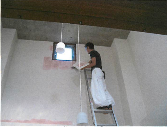
施工の様子①
