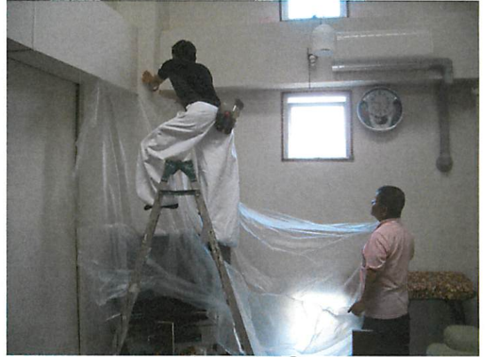
施工の様子②
