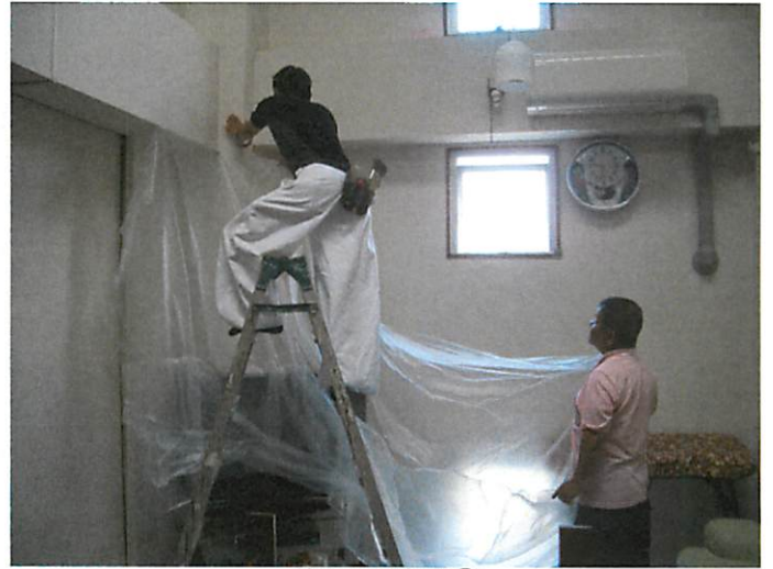
施工の様子②
