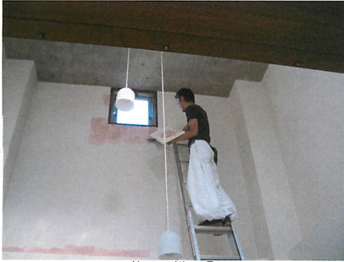
施工の様子①
