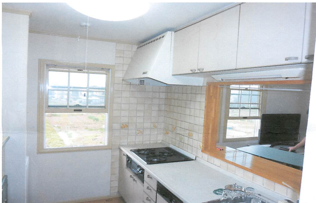
改修前① (旧 2F キッチン)
