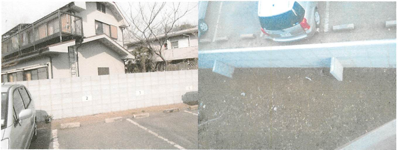
改修後の外壁
