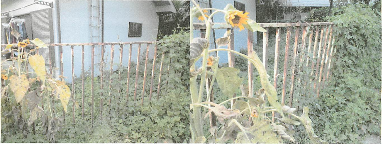
改修前の外壁
