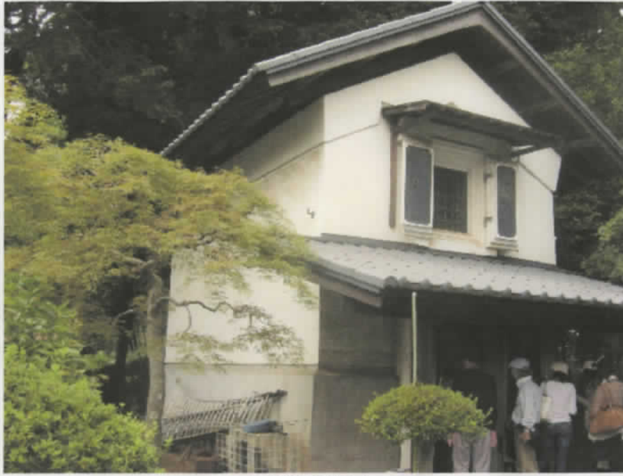
土蔵調査状況
